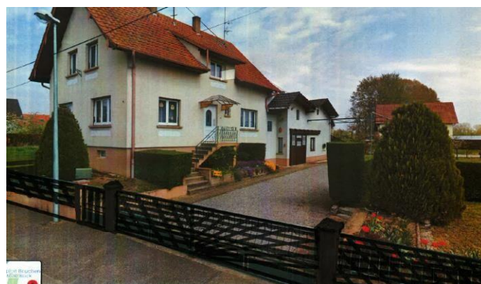
Création d'une clôture : remplacement du grillage sur mur bahut et remplacement portail
